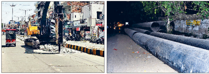
रोहतक। पाइप लाइन बिछाने के लिए तोड़ी जा रही सड़क एवं सड़क पर रखी हुई पाइप।
